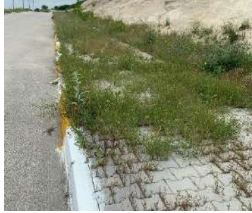
Şekil 8: Güzergâh 2 üzerinde bulunan kaldırımlarda bitki bakımı sorunu
